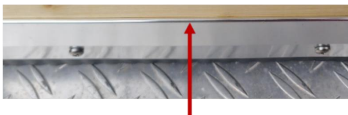
Övre kanten på en installerad lista av den vinklade typ
