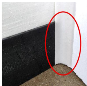
under polymersidosöm installerad på sidostolpen
