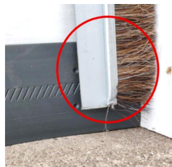
under borsttätning monterad på dörren
