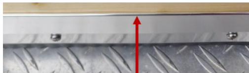
Övre kant på en monterad vinklad mattlist i aluminium
