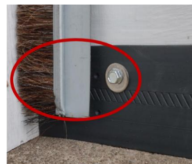
sidotätning monterad på dörr
