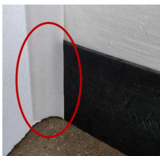
under polymersidosöm installerad på sidostolpen
