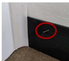
sidotätning monterad på sidokarm
