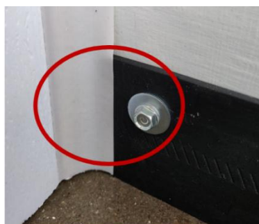
sidotätning monterad på sidostolpen
