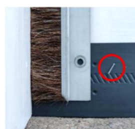
sidotätning monterad på dörr
