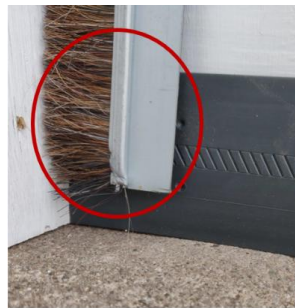
under borsttätning monterad på dörren
