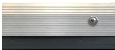
Skadad del av AIO dold bakom monteringslisten
