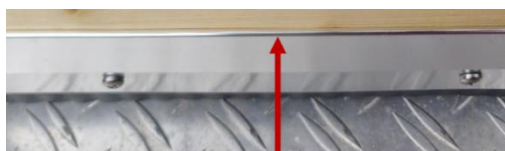
Borde superior de un borde angular de aluminio para alfombras instalado
