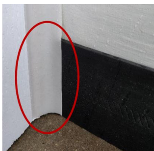
debajo del sello lateral de polímero instalado en el marco lateral
