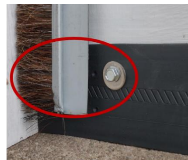
Sello lateral instalado en la puerta
