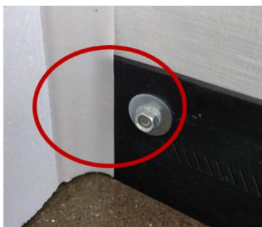
sello lateral instalado en el lateral de la jamba
