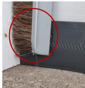
Sello lateral bajo el cepillo instalado en la puerta
