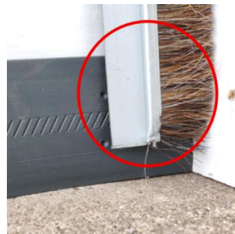
Sello lateral bajo el cepillo instalado en la puerta
