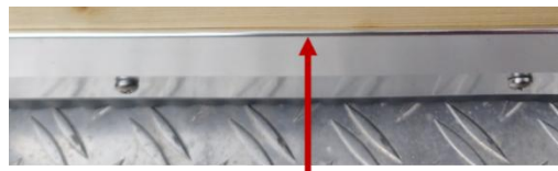
górną krawędź zamontowanej aluminiowej listwy wykończeniowej do dywanówcarpet
