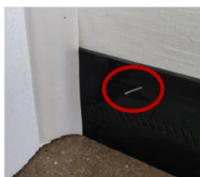
uszczelka boczna zamontowana na ościeżnicy
