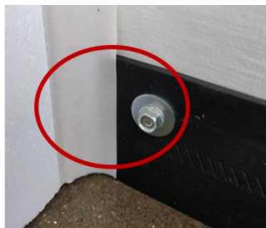
uszczelka boczna zamontowana na ościeżnicy bocznej
