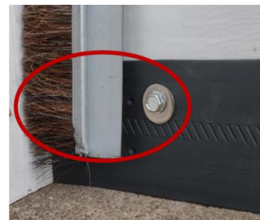
uszczelka boczna zamontowana na drzwiach
