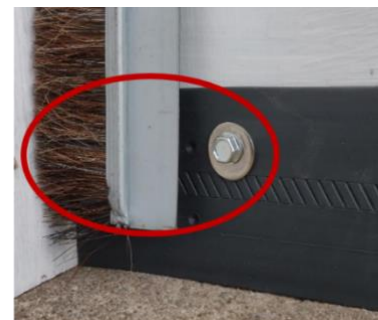
uszczelka boczna zamontowana na
