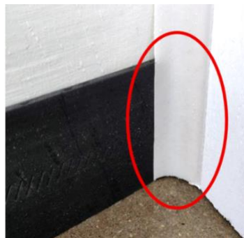
pod polimerową uszczelką boczną zamontowaną na ościeżnicy bocznej
