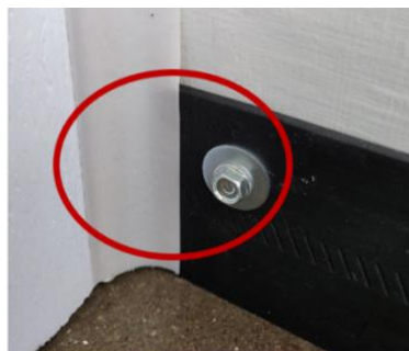
uszczelka boczna zamontowana na ościeżnicy
