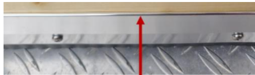
górną krawędź zamontowanej aluminiowej listwy wykończeniowej do
