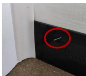
uszczelka boczna zamontowana na ościeżnicy
