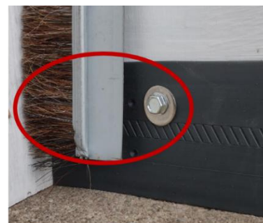
Guarnizione laterale installata sulla porta
