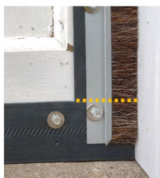
Adiacente con guarnizione laterale a spazzola
