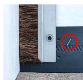
Guarnizione laterale installata sulla porta
