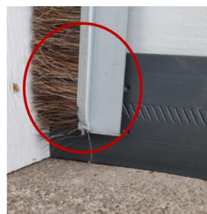
guarnizione laterale sotto il pennello installata sulla porta
