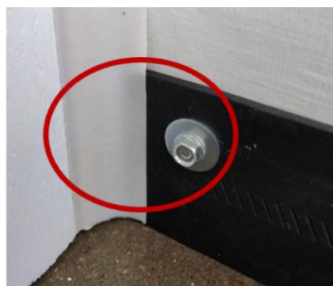
guarnizione laterale installata sul montante laterale
