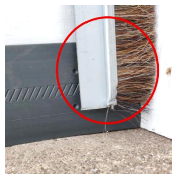
guarnizione laterale sotto il pennello installata sulla porta
