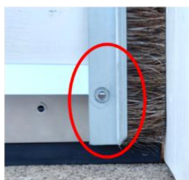
Nascosto dietro le guarnizioni a spazzola sulla porta, sullo stipite laterale
