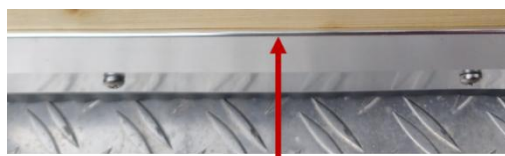
bordo superiore di un profilo angolare in alluminio per moquette installato
