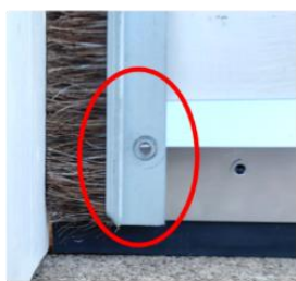
Nascosto dietro le guarnizioni a spazzola sulla porta, sullo stipite laterale
