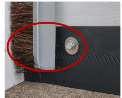
joint latéral installé sur la porte
