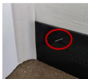
joint latéral installé sur le montant latéral
