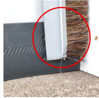
joint latéral sous la brosse installé sur la porte
