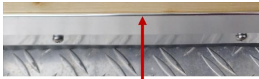
bord supérieur d'une bordure en aluminium coudé pour moquette
