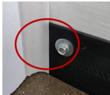
joint latéral installé sur le montant latéral
