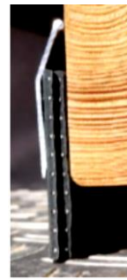
Dubbelskiktsinstallation med 51 mm bred hög monteringslista
