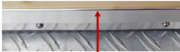
Övre kanten på en installerad liste av den vinklade platta stångtypen
