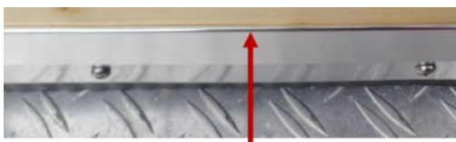
Övre kant på en monterad vinklad mattlist i aluminium
