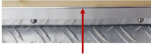
Borde superior de un borde angular de aluminio para alfombras instalado
