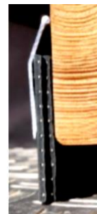
Instalación de doble capa con un ribete para alfombra de 51 mm (2 in) de ancho.
