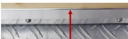
Górna krawędź zamontowanej kątowej listwy aluminiowej do
