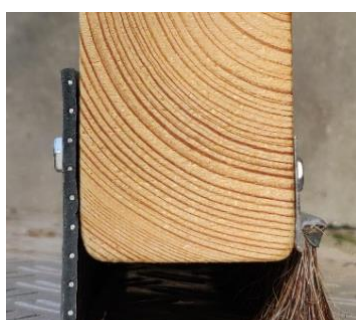
Montaż po przeciwnych stronach
