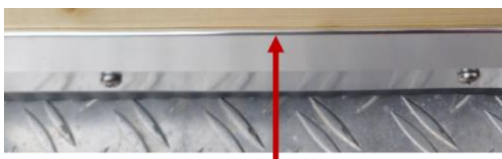
Bordo superiore di un tappeto angolare in alluminio installato trim
