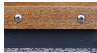
en monteringslist av matchande / målat trä
