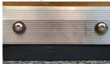
en monteringslist av aluminium
